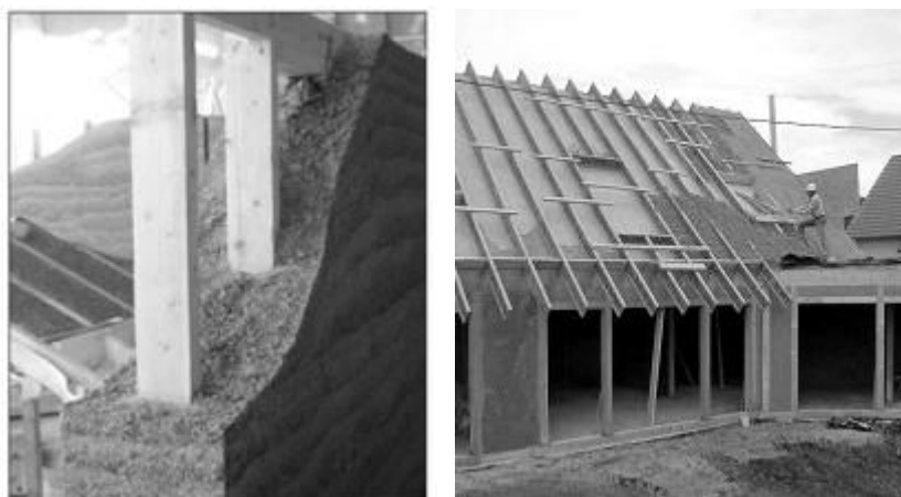
1. att. Kaņepju kaļķbetons kā sienu materiāls un jumta izolācijas materiāls (Woolley, 2007)
